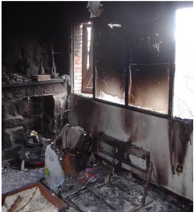
Imagen 70. Continuidad de las llamas del exterior al interior de la vivienda por el acristalamiento, punto débil de la vivienda (Fuente: Caballero, D.)
