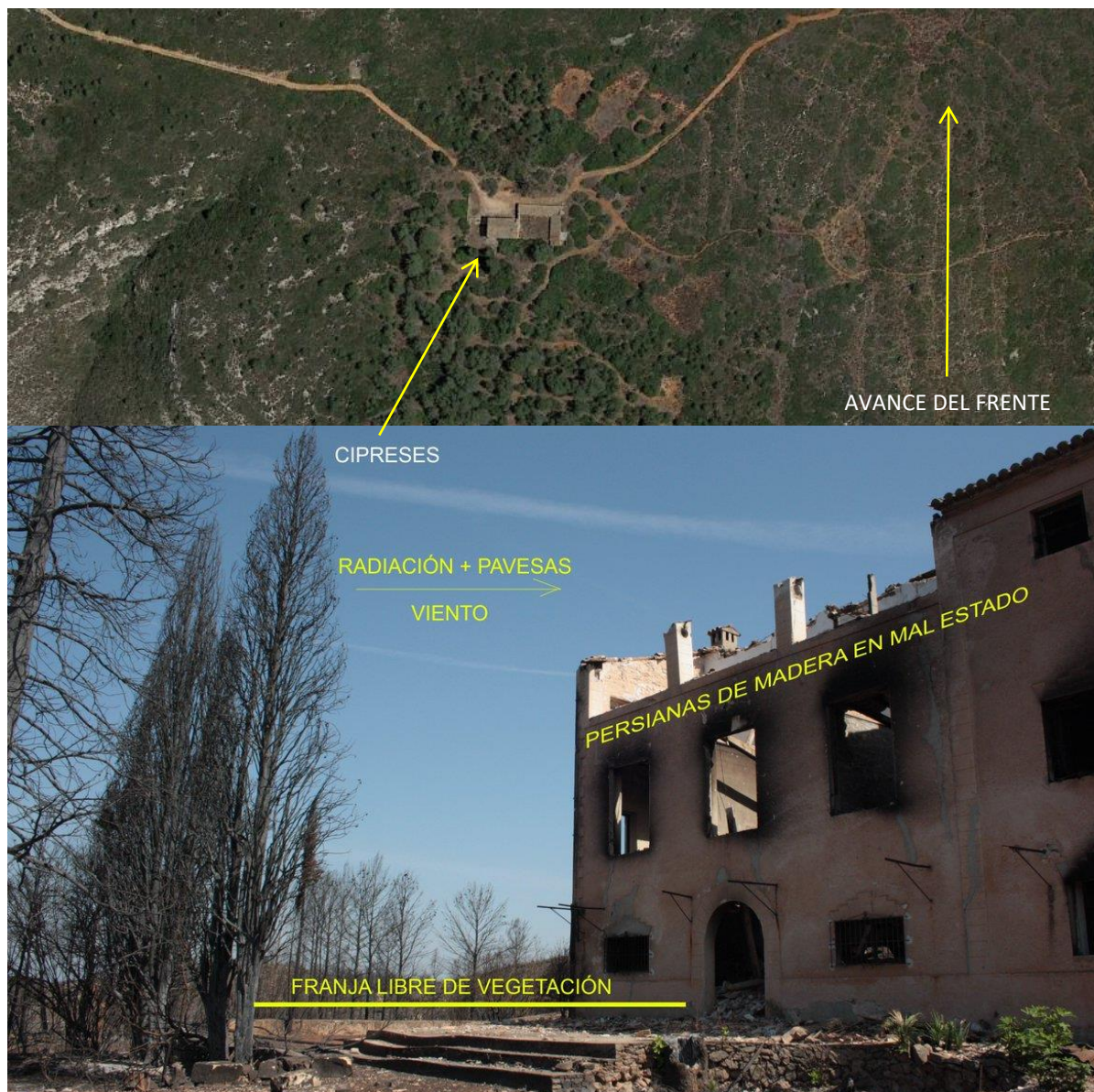
Imagen 26. Construcción aislada en zona forestal afectada por el incendio de Carcaixent en junio de 2016. Pese a estar en una zona llana el impacto del fuego acaba con la destrucción total de la edificación. La vegetación en forma de muro verde circundante (Cupresáceas y Pináceas salpicadas de antiguos cultivos en su interior) condiciona totalmente su supervivencia. Fuente: Dalmau, F. 2016. Medi XXI GSA
