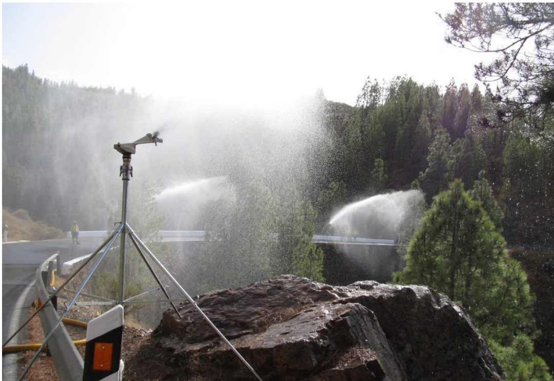
Imagen 98. Despliegue de línea de defensa SIDEINFO para protección de infraestructura vial crítica abastecido con carrusel de vehículos autobomba. Operativo del Cabildo de Gran Canaria. Artenara, 2013
