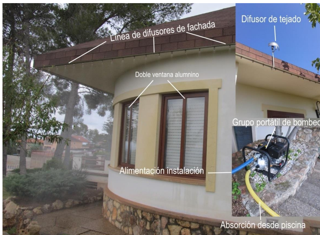
Imagen 96. Sistema de Defensa SIDEINFO doméstico. Difusores fachada y tejado conectados a piscina de vivienda en área de Interfaz Urbano-Forestal. Fuente: Medi XXI GSA.
