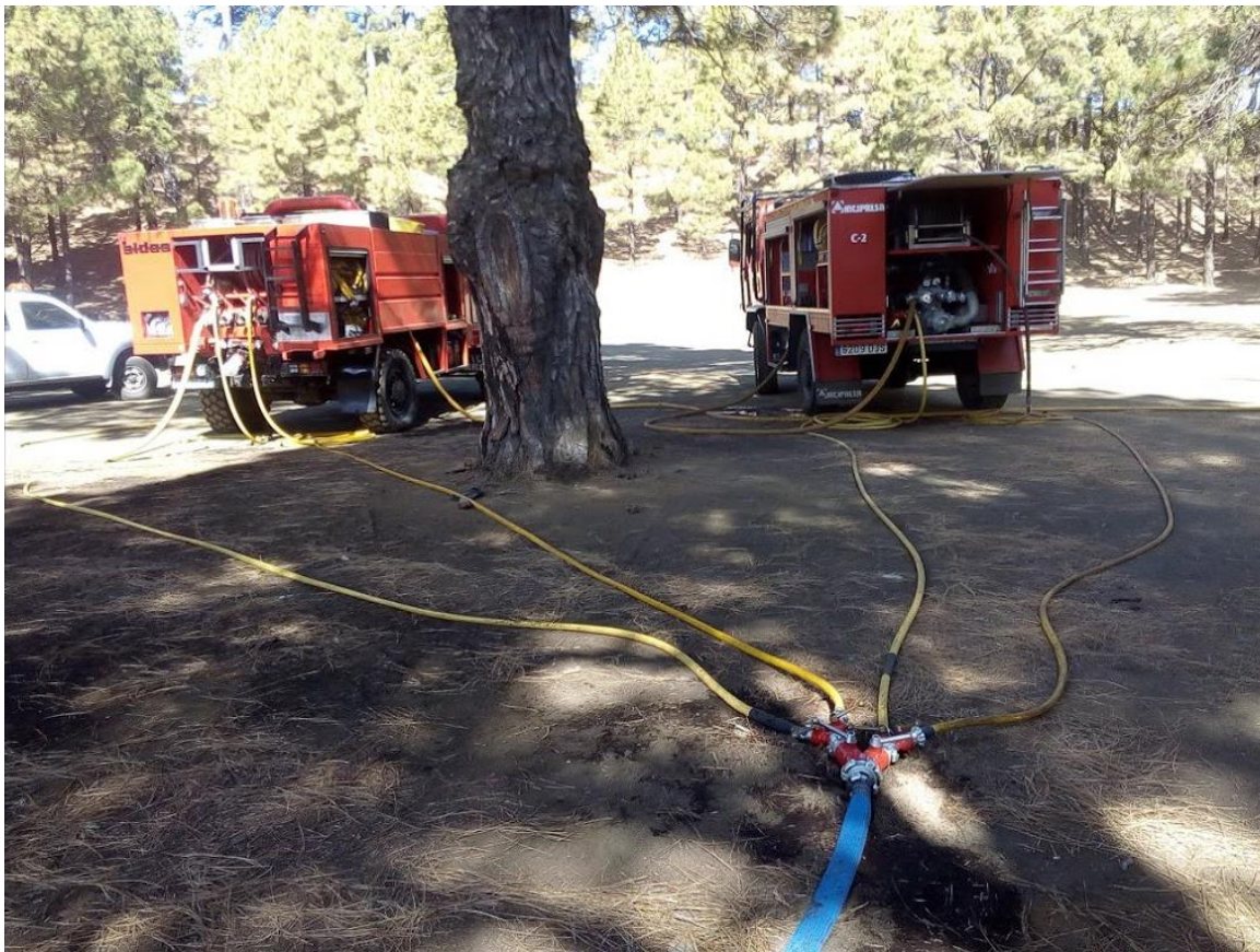
Imagen 93. Construcción de tendido de largo alcance para defensa de zona de IUF con autobombas dispuestas en paralelo. Utilización de mangueras más resistentes en el tramo central (azul) para trabajar con seguridad en alta presión combinada. Fuente: Dalmau Rovira, F.
